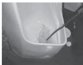
小便器配管を 洗浄中
