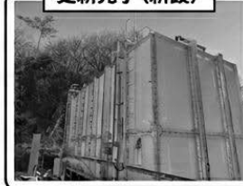
更新完了（新設）
